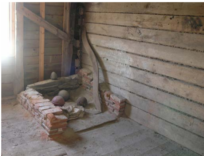
Rester av grua i 2. etasje.
