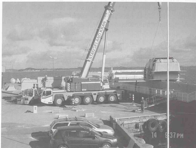
Kranbilen heiser modulane om bord i båt som skal føra dei til oljefeltet til havs.
