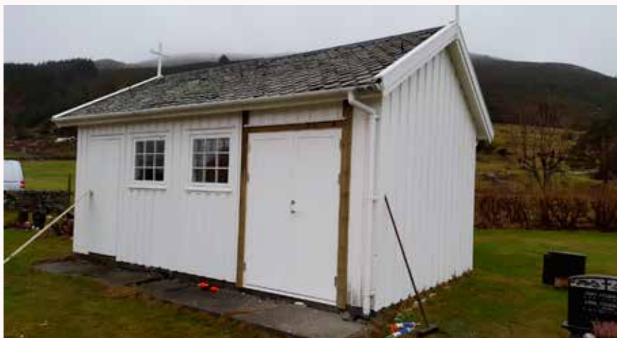
Det har kome ny dør i det gamle bårhuset.
