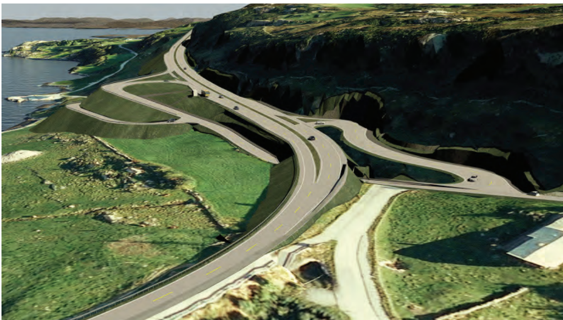
Nytt planfritt kryss og avkjøringar på E39 ved Austre Bokn, her illustrert i fotomontasje, skal stå klart før opninga av Rogfast. Fotomontasje: Statens vegvesen, Cowi.
