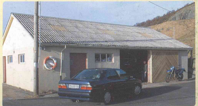
I lagerskuret til det gamle handelslaget på Austre Bokn er det plass til fleire bilar.
