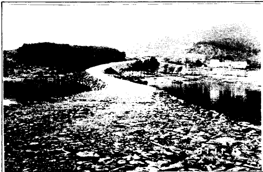
Parsell av den nye rv. 512 ved Susort fra fyllinga og innover mot land.
