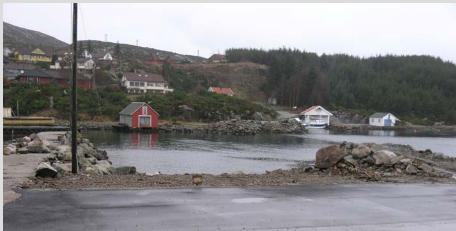
Arbeid på området for småbåtanlegg i vest er alt påbegynt.
