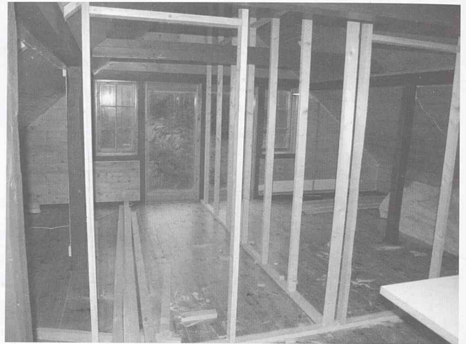
Slik ser leiligheten mot vest i 3. etasje ut før han er skikkeleg avdelt. Rammene viser at det blir 2 kontor som begge får godt med dagslys inn.
