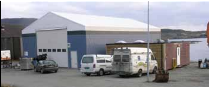
Den nye hallen midt i bildet. Til høgre administrasjonsbygg som også inneheld spiserom.
