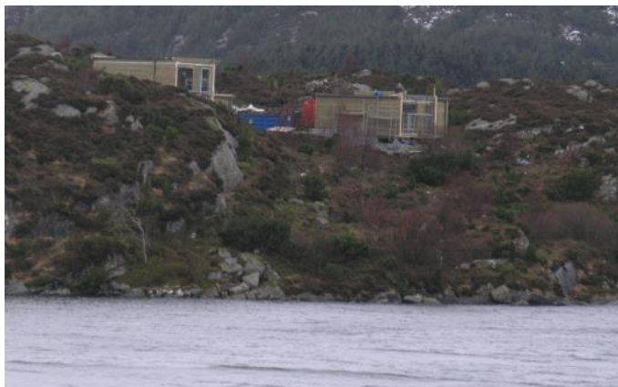
Dei to ferdige hyttene sett frå RV39 nord for Lauplandsvågen.
