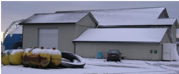
Bygningane til tidlegare Bokn Fiskemottak slik dei ligg i dag. Plasthallen t.v. på kaien skal fjernast.
