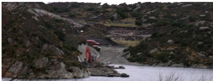
Gravemaskin i arbeid med utfylling for naust og brygger. Bildet er tatt frå RV39 nord for brua over innløpet til Lauplandsvågen.
