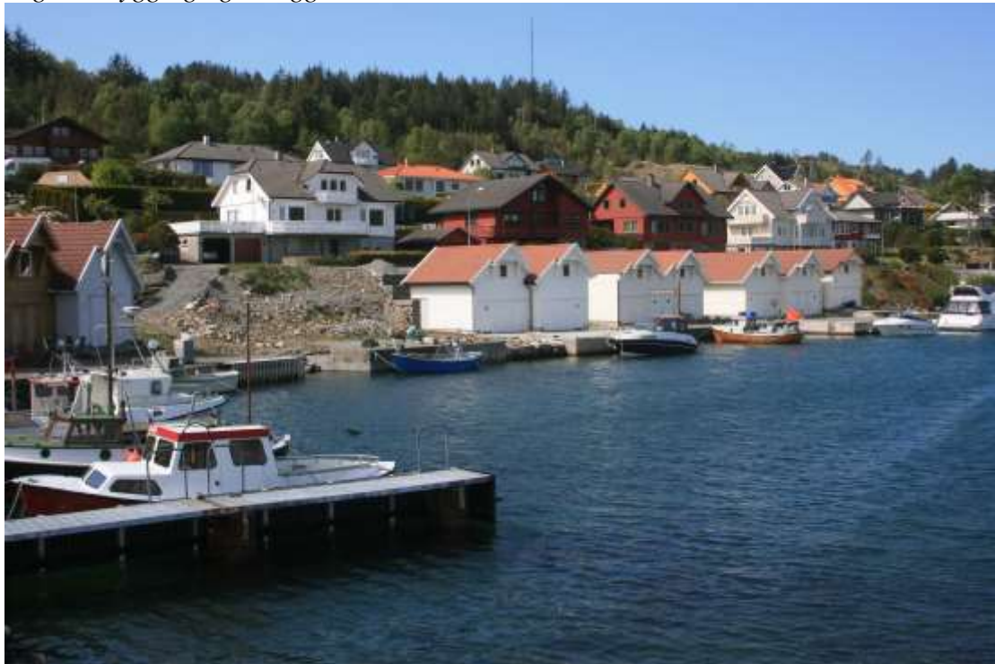
Ny naustbebyggelse ved Hålandssjøen
