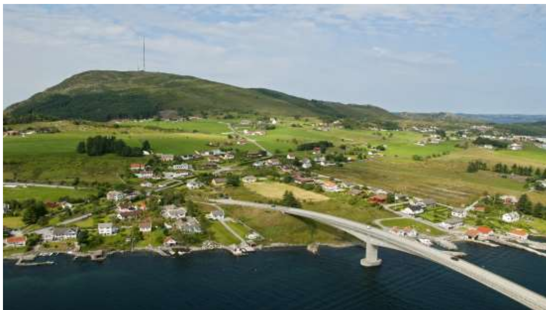
Del av Alvestadkroken med Boknasundbrua og Boknafjell i bakgrunnen Foto: Vestfoto
