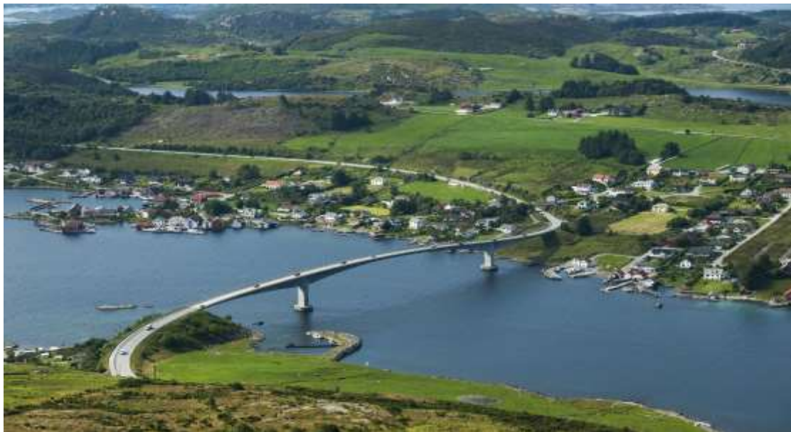
Boknasundbrua med Alvestadkroken Foto: Vestfoto
